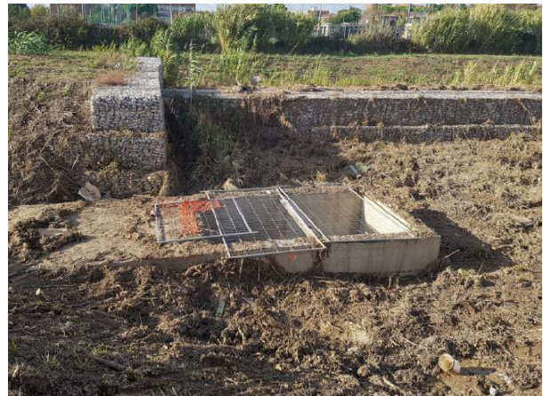
Scatolare della cassa RM3bis ripulito dai detriti dopo qualche giorno dalla nostra segnalazione
