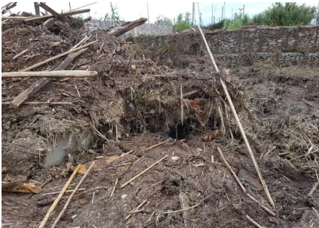
Scatolare della cassa RM3bis, che doveva permettere il passaggio dell'acqua alla cassa RM4
